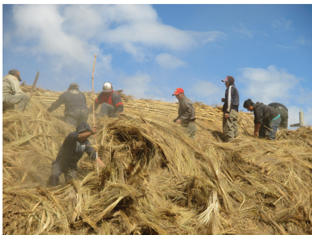
Figura 6: Trabajos de retechado de la iglesia de Incahuasi.
