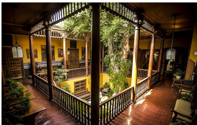
Lima: casa de Jerónimo de Aliaga, patio rodeado por una galería sustentada en columnas de madera. La vivienda ha tenido varias refacciones y modificaciones desde el siglo XVI al presente. Imagen: propia, 2019.
