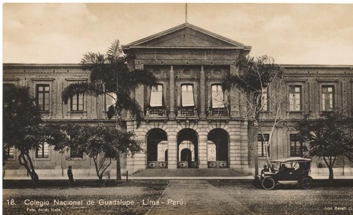
Foto 01. La fachada académica 1 que muestra la postal sigue una rigurosa composición neoclásica. Está articulada con un cuerpo central resaltado (frontispicio, fachada principal con coronamiento triangular en el frente de ventanas), un orden monumental de pilastras que abrazan los niveles superiores, óculos decorativos, un gran frontón triangular clásico coronando el eje principal y un almohadillado o tratamiento rústico en el primer nivel. Imagen: Avilés Hnos. y editor de la postal: Juan Baselli. Año: 1920.
